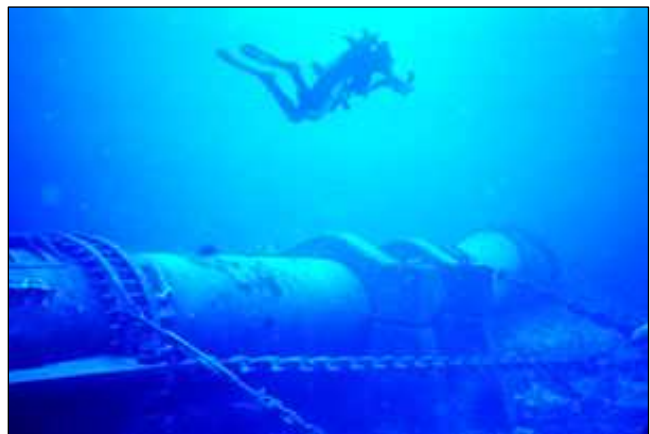
Figure 4: Photo d'un tuyau de 1,5m de diamètre ancré sur le fond marin
