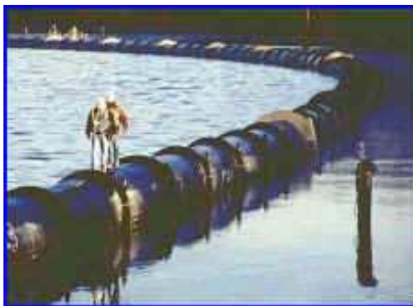
Figure 49 : Conduite d'Eau Froide assemblée avant immersion (source : site web Makai)
