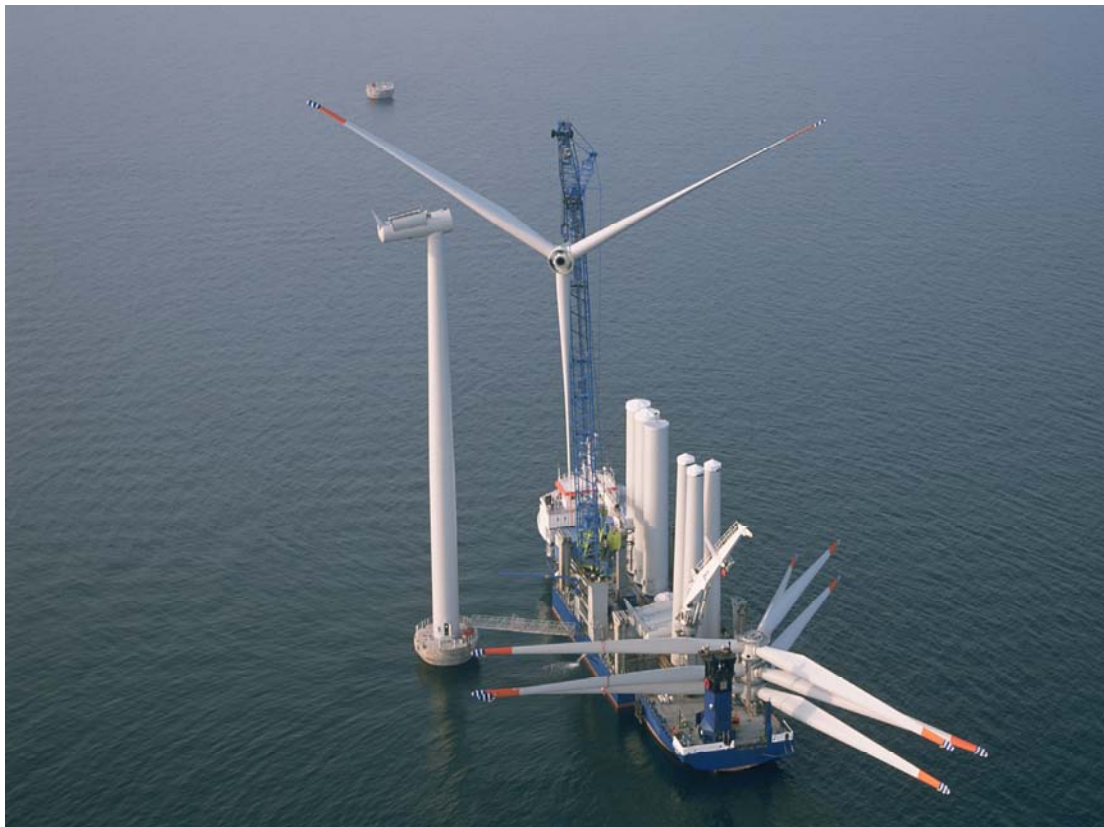
Figure 3 : Montage des éoliennes de 2,3MW de Nysted (Danemark) par un navire spécialisé Mise en place du rotor à 80m au dessus de l'eau (Courtesy of A2SEA)
