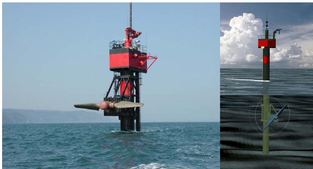
Figure 9 : Photographie d'un prototype d'hydrolienne de 300 kW La nacelle est montrée ici avant son immersion dans le courant . A droite, vue d'artiste de l'hydrolienne en fonctionnement (Projet Marine Current Turbines Ltd) - Réf : (9)
