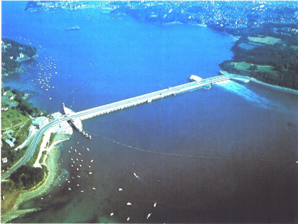
Figure 15 : Vue aérienne de l'usine marémotrice de La Rance.
