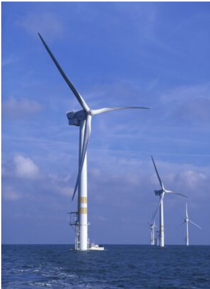
Figure 2 : Éoliennes de 3,6MW à Arklow Bank (Irlande) Le bateau de service donne l'échelle. Le rotor a un diamètre de 104 m. Ref : (2)
