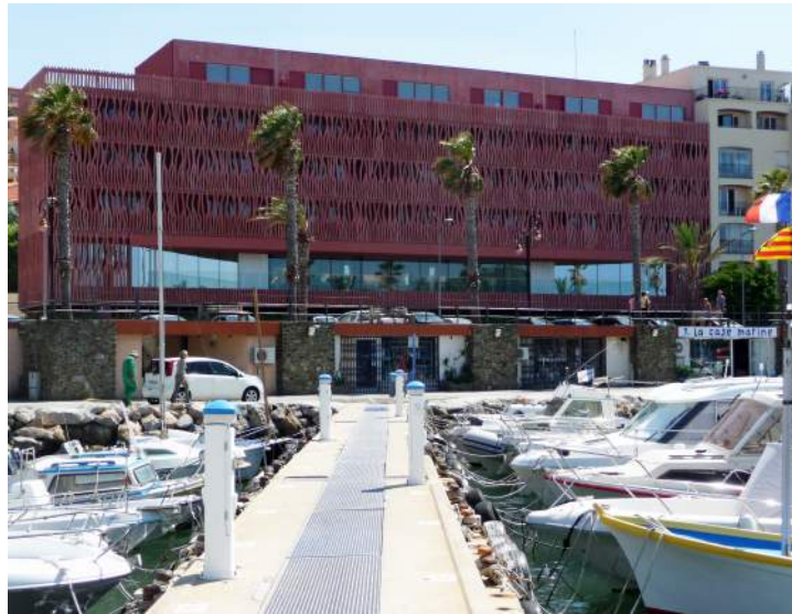
29 Nouveau bâtiment d'hébergement du Laboratoire Arago qui comportera également un aquarium public.
